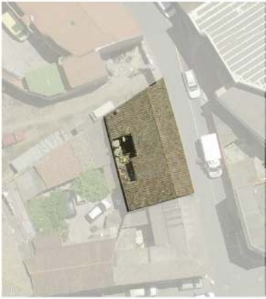
Ortofoto dello stato attuale
